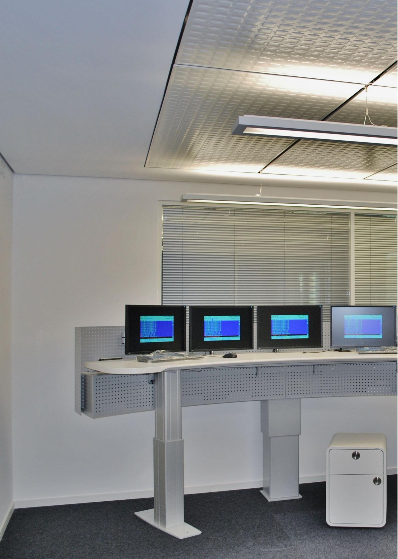
Der wassergefüllte KIGO Wärmetauscher kann akustisch mit einer Holzdecke verglichen werden. Durch die Isolierung der Rückseite der Platte können die akustischen Eigenschaften wesentlich verbessert werden.
