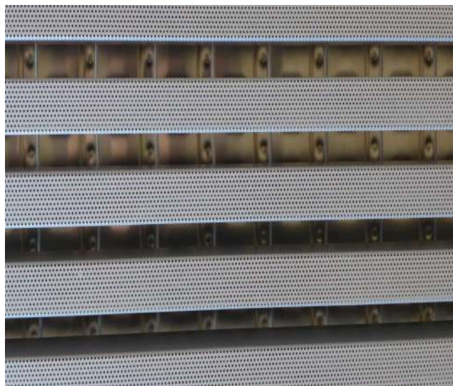
Lames acoustiques en métal micro-perforé.
