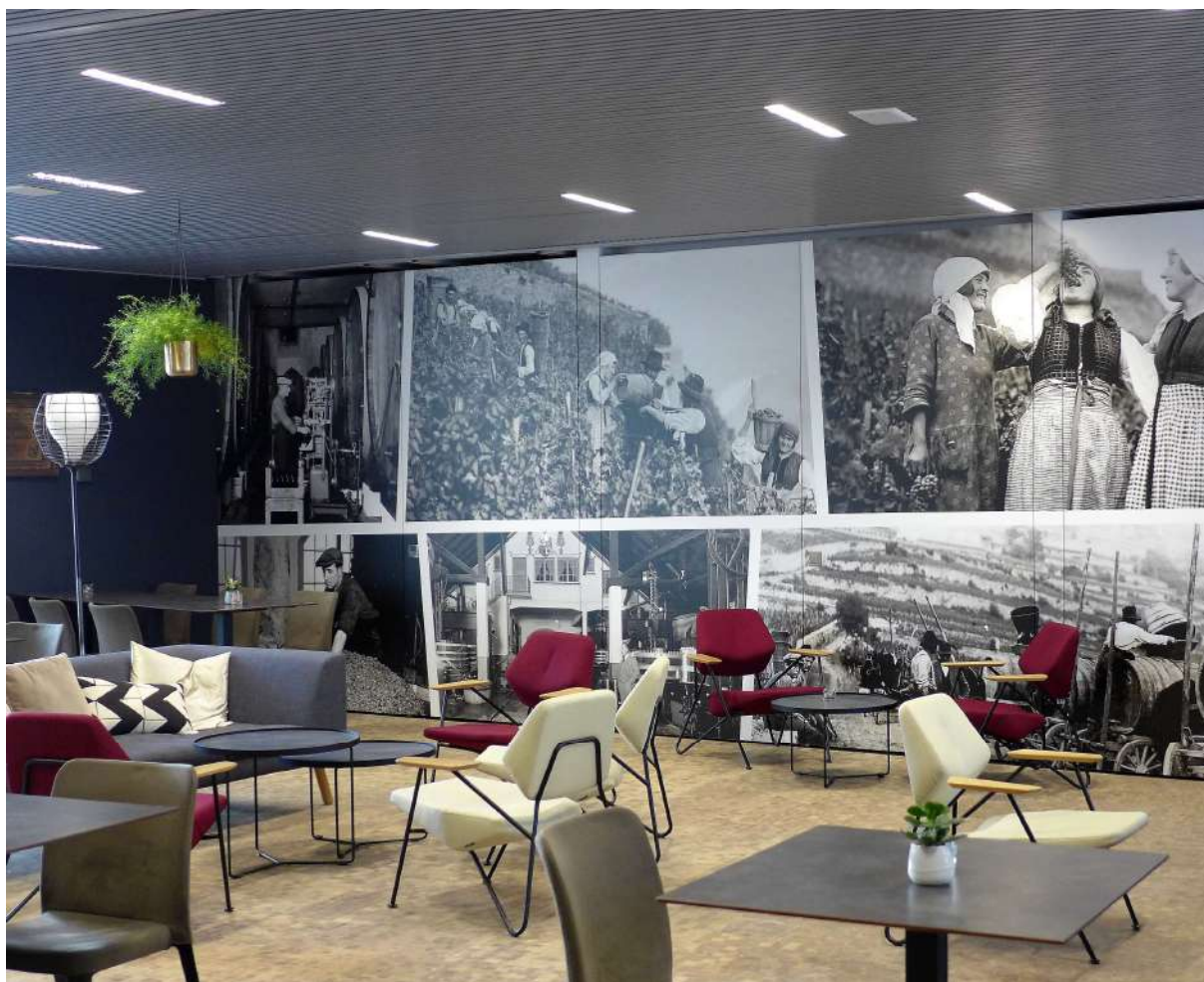
Faux plafond en lames acoustiques métalliques micro-perforées
